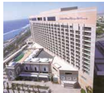
Hilton Hotel, Jeddah
